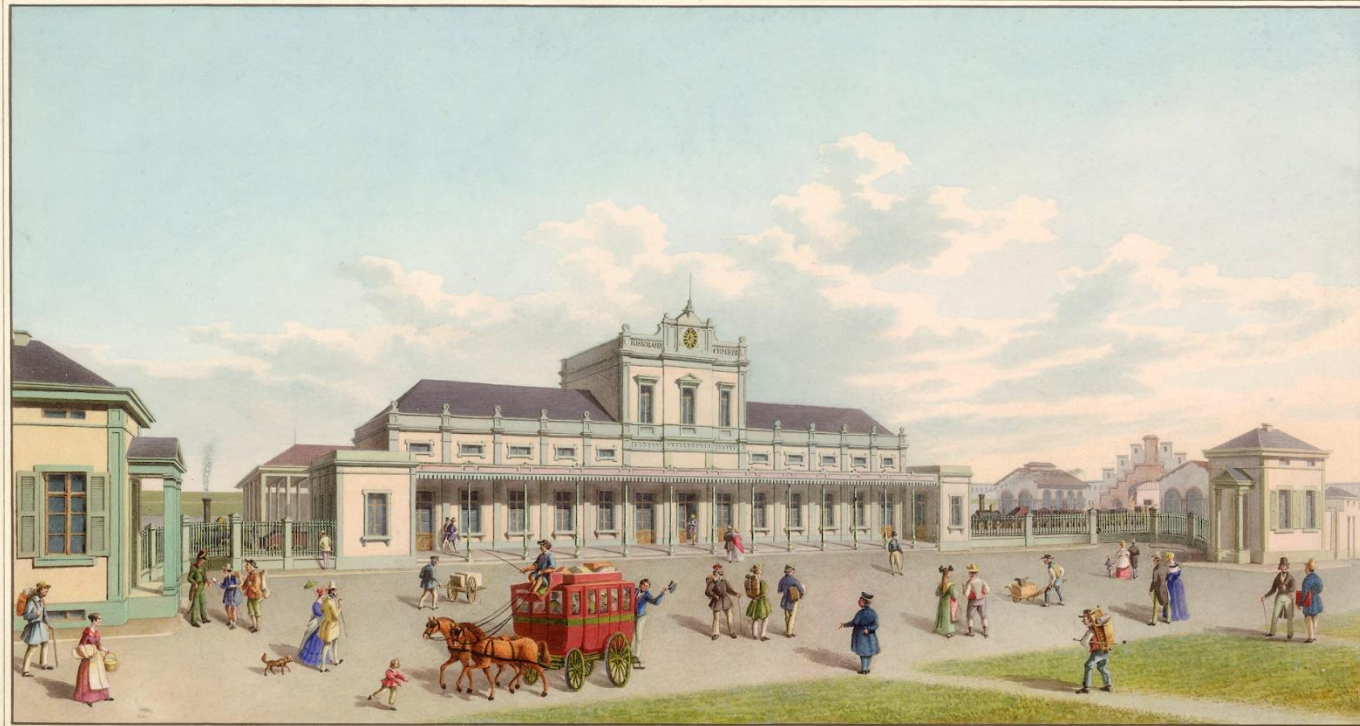
Erster französischer Bahnhof in Basel, 1844/45. Ansicht von der Strassenseite.
